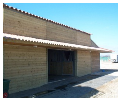
Bardage complet de bâtiment en dur avec création d'un avant-toit de 1m50
