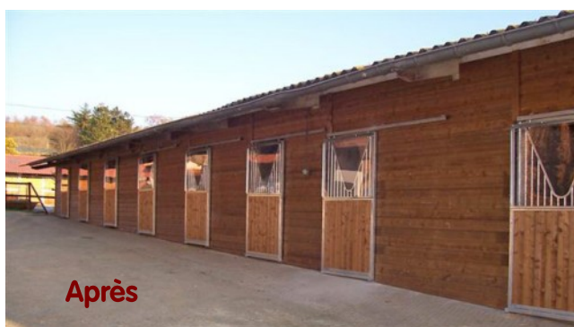
Rénovation de boxes extérieures avec bardage bois et installations de portes coulissantes
