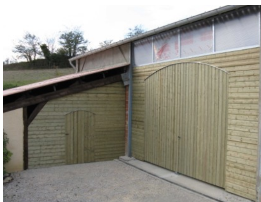
Bardage et portail sur grange toulousaine
